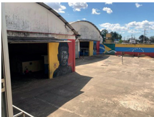
Figura 2: Abrigo municipal do Tapanã
