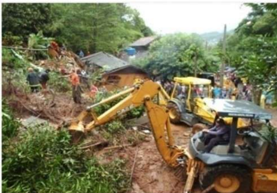
Figura 2. Cenário pós-evento em 2011 no bairro Saibreira do município de Igrejinha-RS. Fonte: CEPED-RS/UFRGS, (2014).
