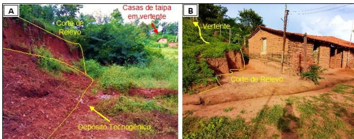
Figura 7. Ocupações e gênese do Tecnógeno no Bairro Verde Lar, sub-bacia PD07. Fonte: Os autores (2020). Em A, cortes de relevo e formação de depósitos tecnogênicos; em B, Casa de taipa com matéria prima oriunda de corte de relevo.
