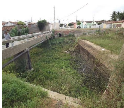
Figura 14 - Residências próximas do reservatório. Fonte: Arquivo de campo (2016).
