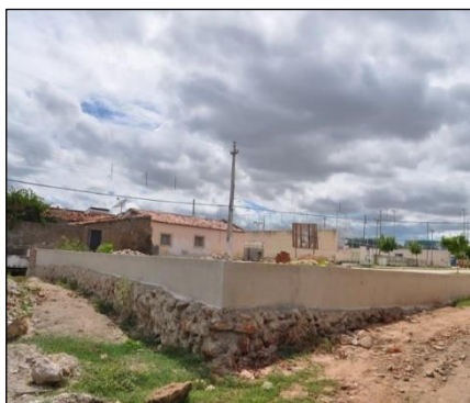
Figura 12 - Construção de praça. Fonte: Arquivo de campo (2016).
