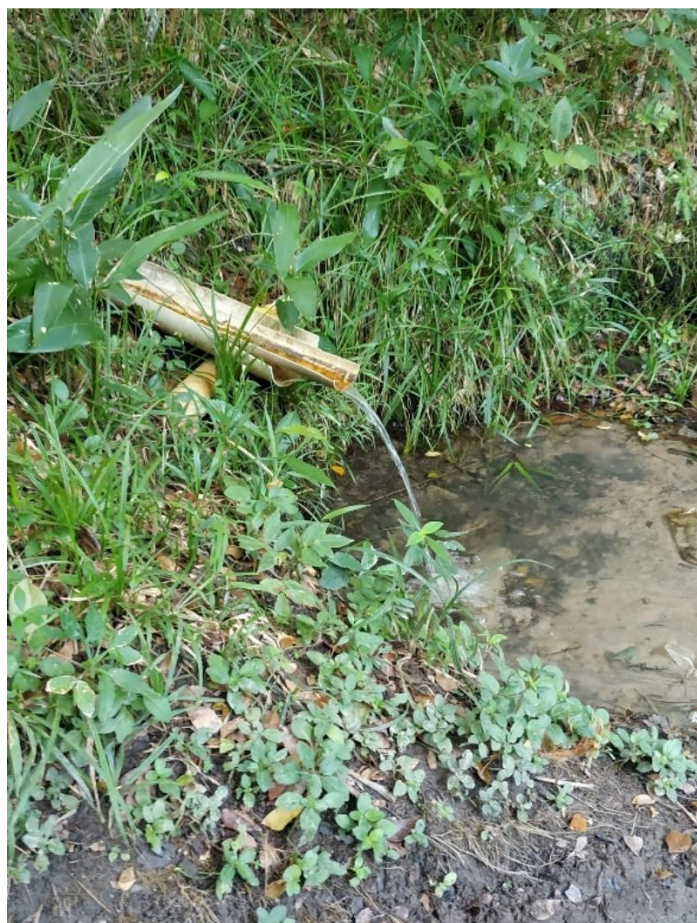
Figura 2. Sistema de captação de água com resquícios de material férrico. Fonte: O autor.
