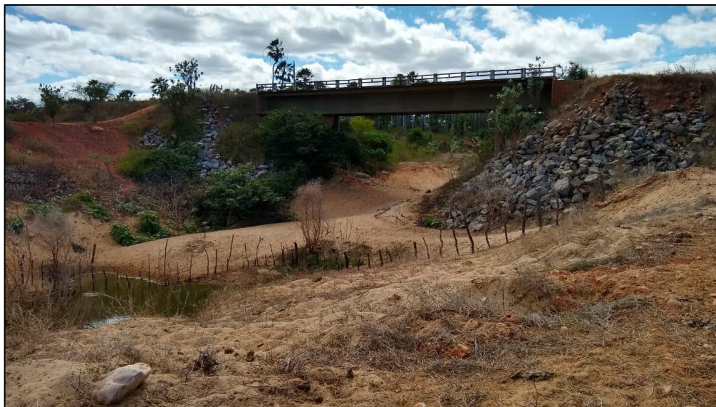
Figura 15: Leito do canal com maior largura e profundidade. Fonte: Rocha (2019).
