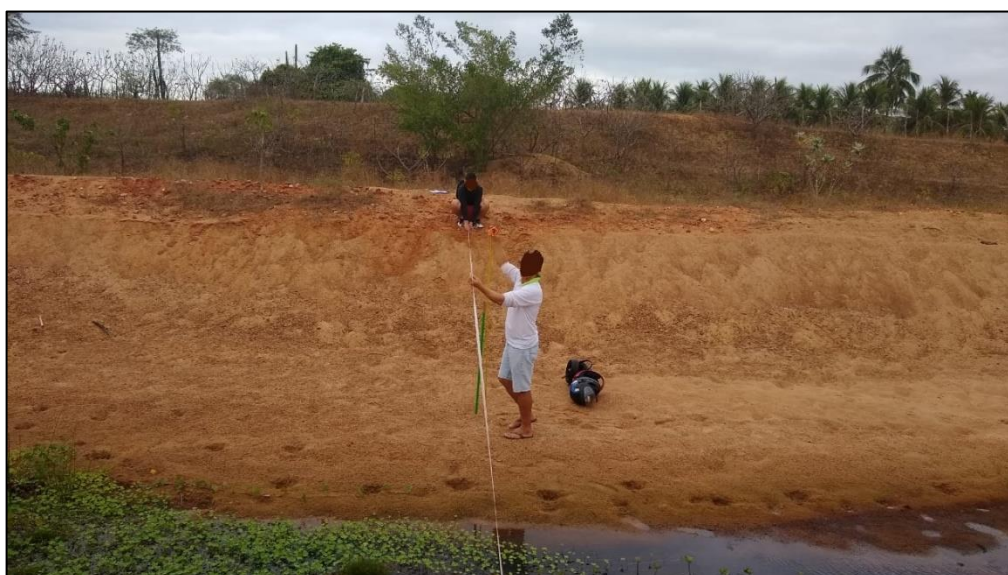
Figura 12: Indícios de erosão e banco de sedimentos. Fonte: Rocha (2019).
