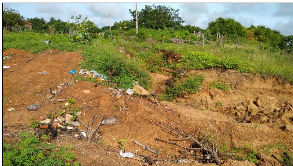
Figura 14: Trecho com presença de resíduos sólidos dentro do leito do Canal do Piató. Fonte: Rocha (2019).
