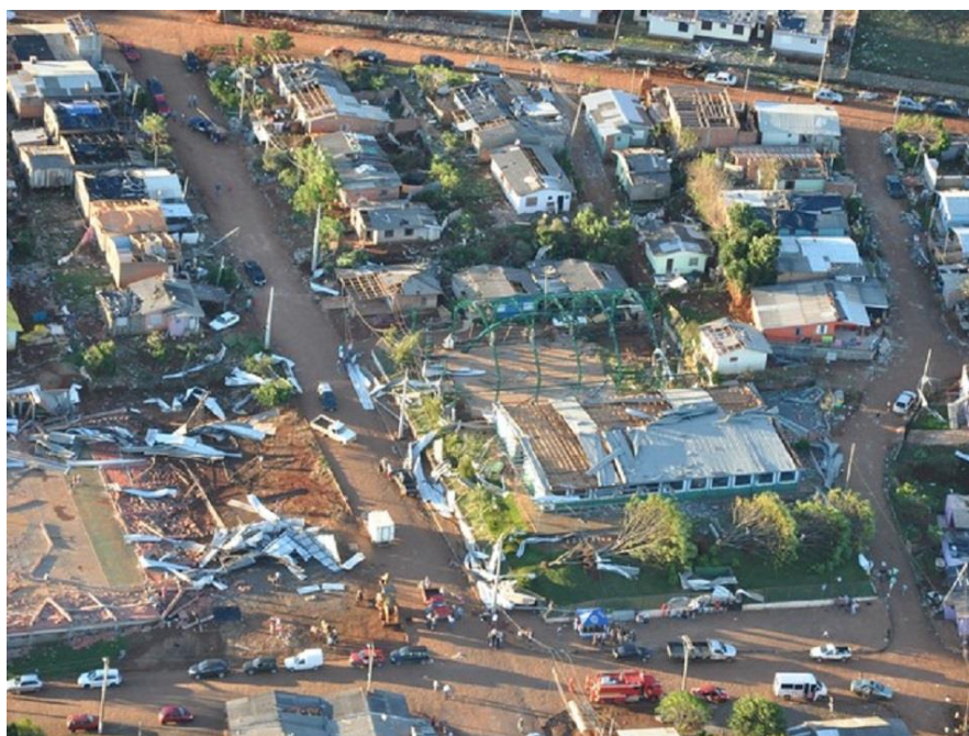
Figura 8. Edificações destruídas em Tapejara – RS, dia 12 de abril de 2014.
