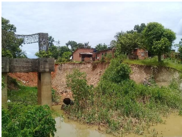
Figura 11 – Área de erosão fluvial no bairro Sobral. Fonte: Registrado pelos autores, dezembro 2019.
