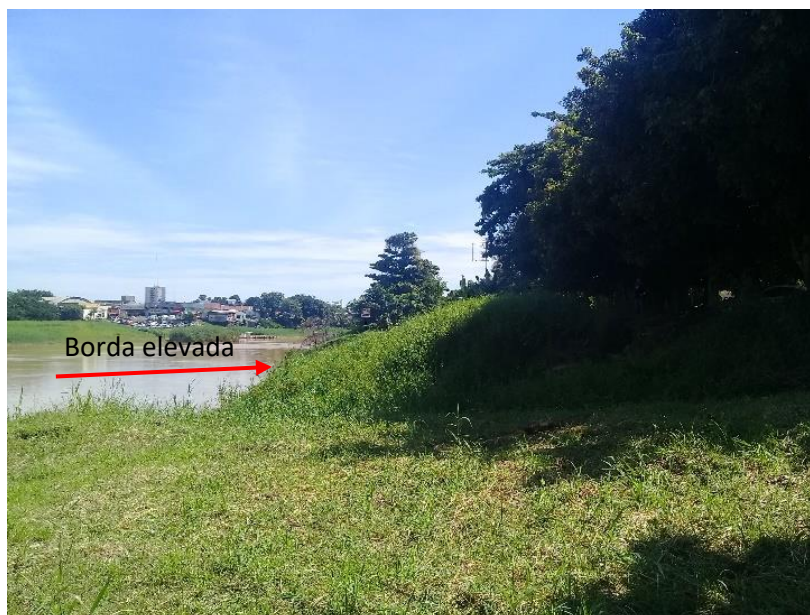
Figura 7 – Diques marginais. Fonte: LIMA, dezembro de 2019.
