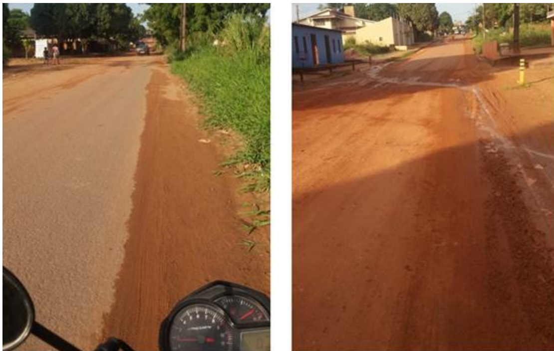
Figura 11. Trecho de verificação 3, localizado na Rua Angelim, no bairro do Maracanã. Fonte: O autor.
