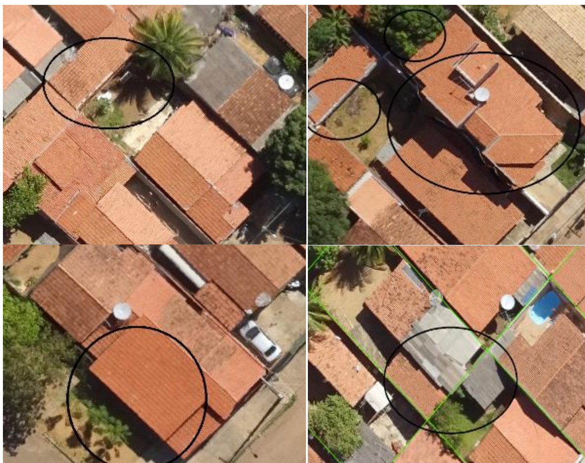
Figura 11. Muros desalinhados, construção anexa e beiral. Fonte: AUTOR, (2018).
