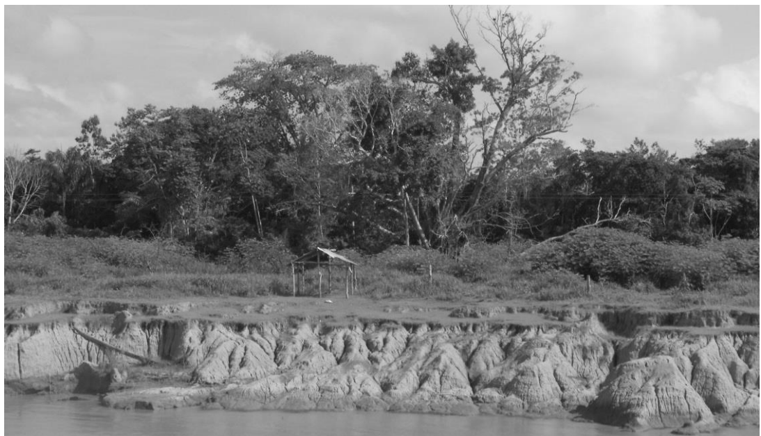
Figura 4: Desativação do lanço de pesca. Fonte: Nascimento. Trabalho de campo, 02.01.2015.
