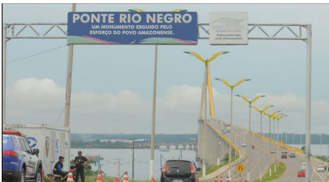
Figura 02. Entrada da Ponte Jornalista Phelippe Daou (Ponte Rio Negro) no sentido Manaus-Iranduba. Fonte: A CRÍTICA (2017).
