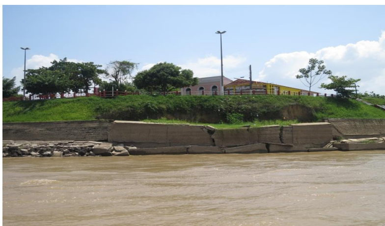
Figura 14. Situação do muro de contenção na Praça do Comunas. Foto: SOUZA (2014).
