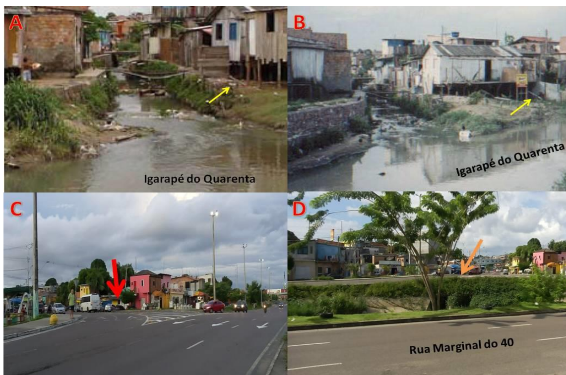
Figura 7. Ocupações irregulares às margens do Igarapé da Feira. Nos lados A (2004) e B (2004) as setas amarelas apresentam a tubulação, o lado C a rua Santa Cruz Machado sobre o igarapé da Freira (seta vermelha) e o lado D (seta laranja) o deságue do igarapé da Freira no Igarapé do Quarenta. Fonte: Almeida (A e B) 2005 e o autor (C e D) 2018. Org.: autor, jan. de 2018.
