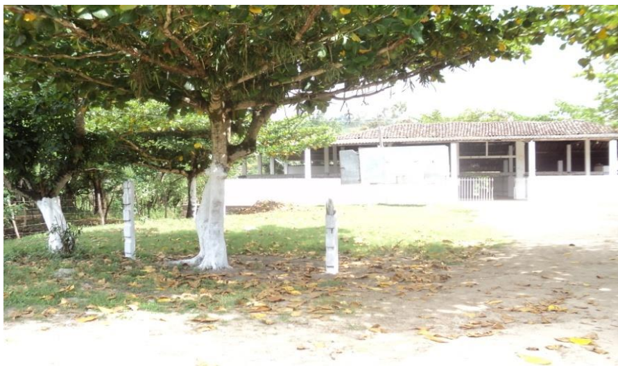
Figura 7: Matadouro público municipal construído às margens do rio. Fonte: Acervo dos autores, 2012.
