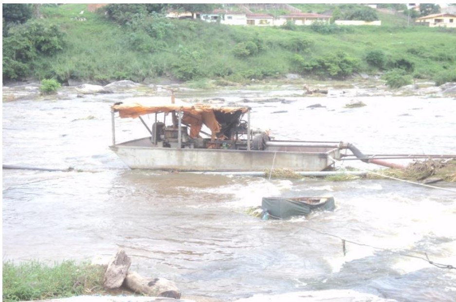
Figura 10: Máquina de dragagem em operação montada pelos próprios trabalhadores. Fonte: Acervo dos autores, 2012.
