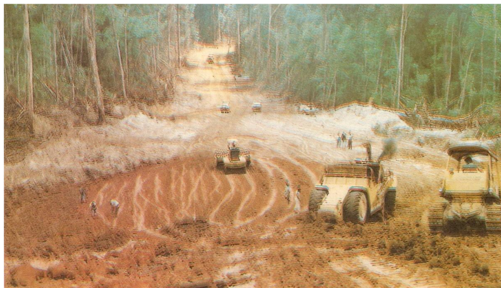
Figura 03. Abertura da BR – 174. Fonte - UHE Balbina - Memória Técnica (1997).
