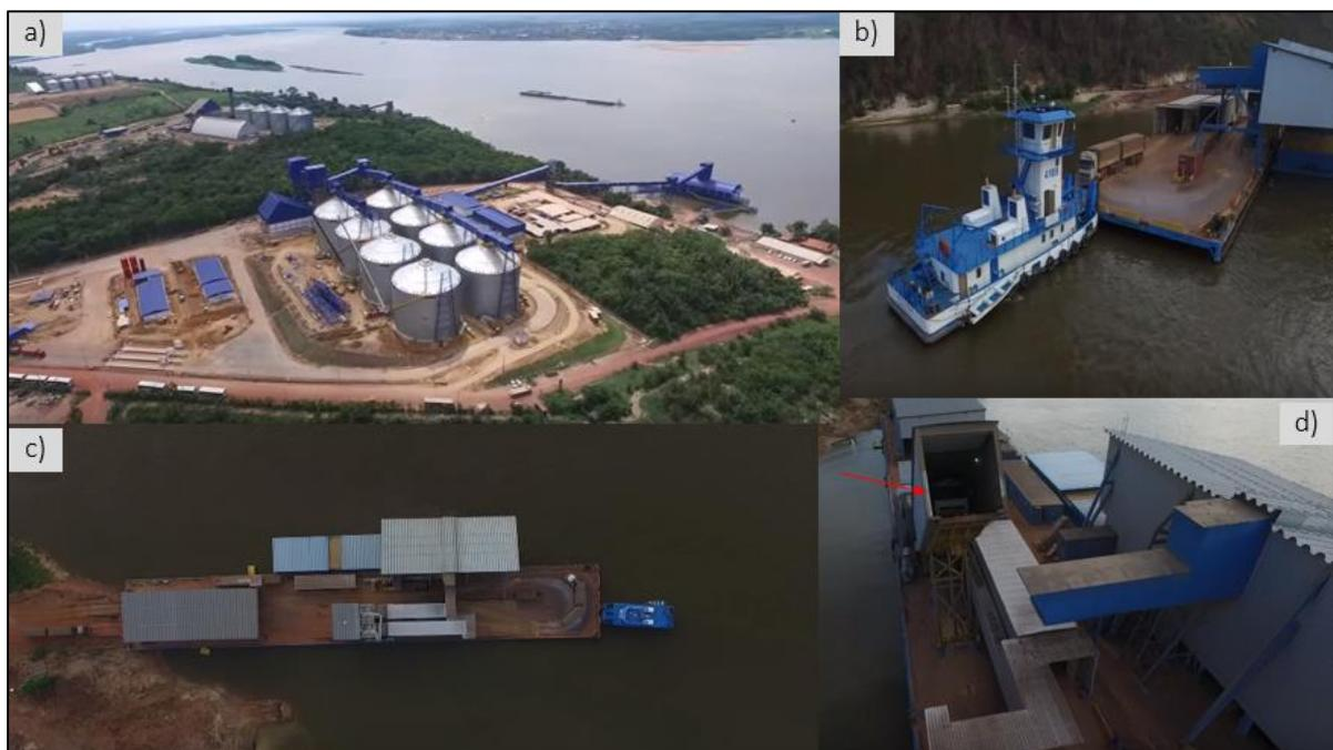
Figura 2. Estação de Transbordo de Carga-ETC no distrito de Mirirituba no mosaico: a) Três ETC,s fixas com silos, píer e tombador de veículos; b) e c) Estação de Transbordo de Carga Flutuante-ETCF construída sobre uma balsa; d) Transbordo de grãos de uma carreta, veículo dentro do tombador de carga em seta vermelha. Fonte: (SAUR, 2016).
