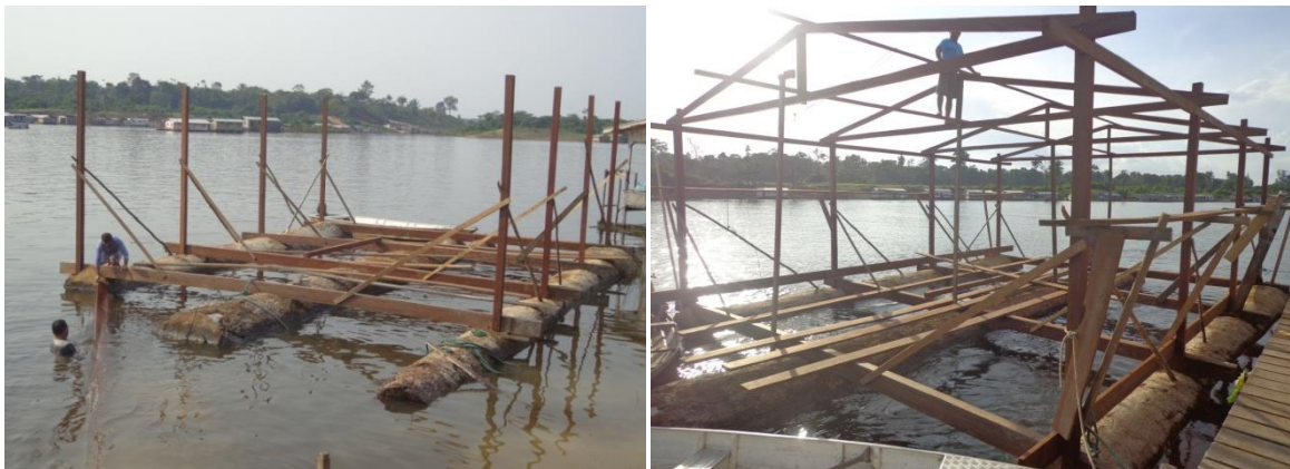
Figura 7: Etapas da construção do flutuante
