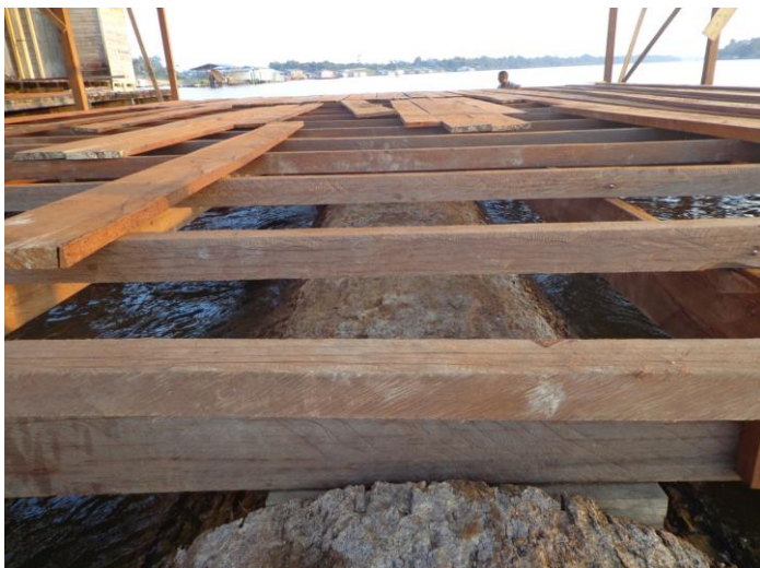
Figura 6: Na correção das vigas, pedaços de madeira são colocadas de baixo.
