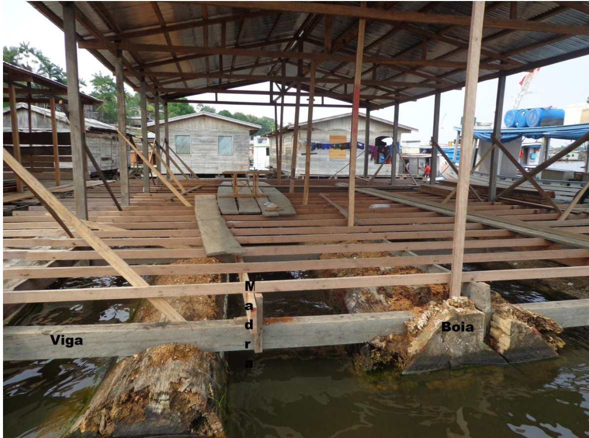
Figura 5: Montagem da estrutura das boias, nivelamento e levantamento da casa.
