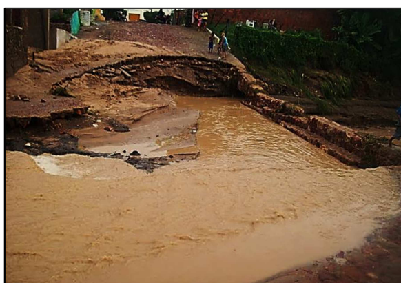
Figura 5: Passagem molhada do riacho dos Côchos destruída após a enchente. Porteiras - CE, 05 de maio de 2011.
