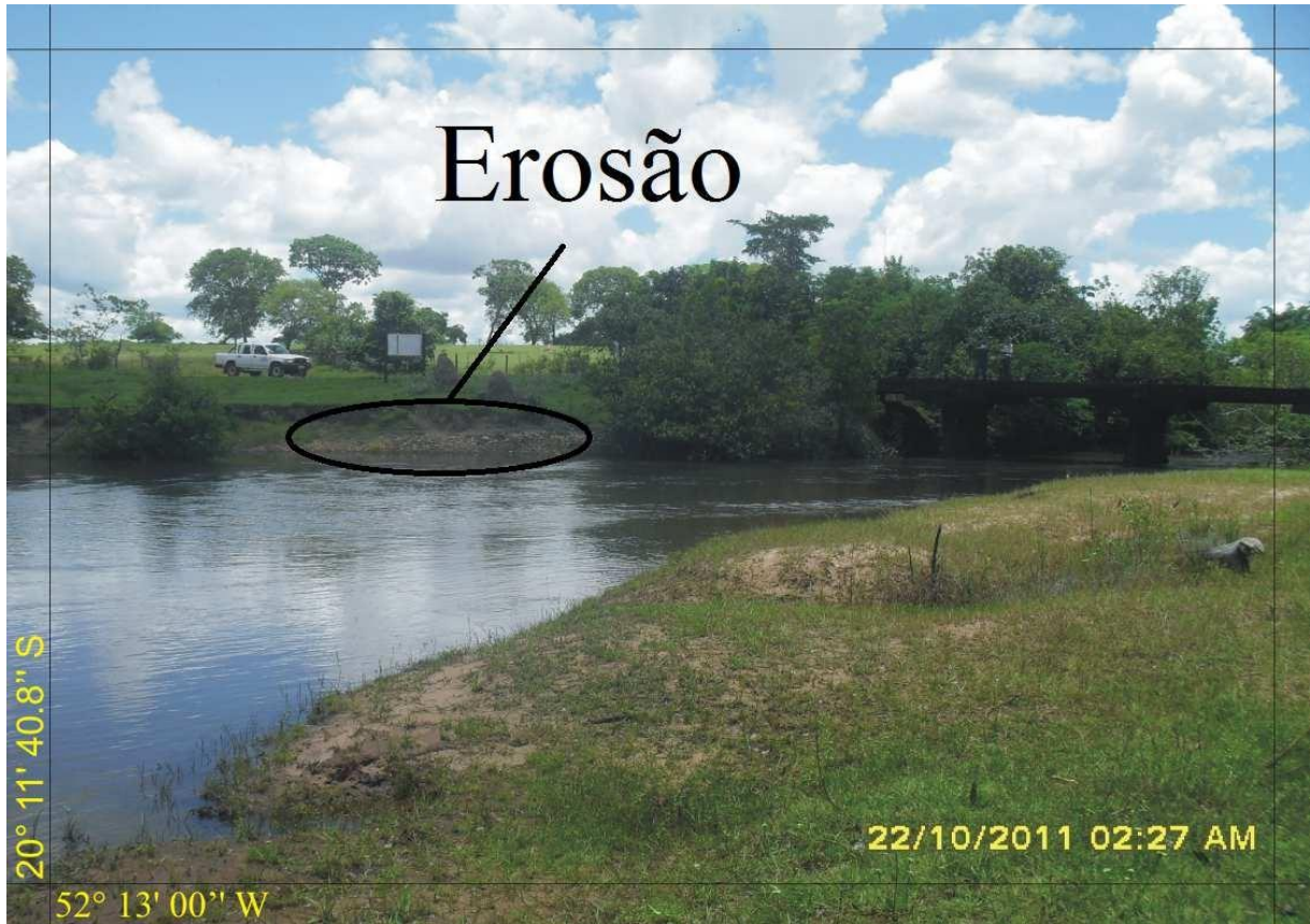
Figura 2: Margem esquerda do Rio da Prata degradada com assoreamento sem APP – Área de Preservação Permanente – assim fica melhor sempre dizer onde vc está e colocar as coordenadas geográficas
