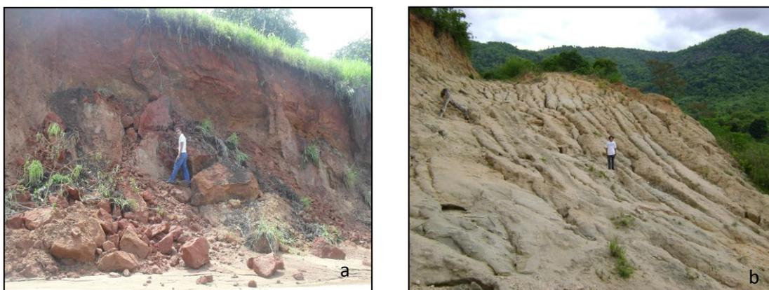
Figura 6 e 7 – a) Desmoronamento em talude de corte nas margens da rodovia PB-077, b) erosão em sulcos e ravinas em área de empréstimo da PB-077.
