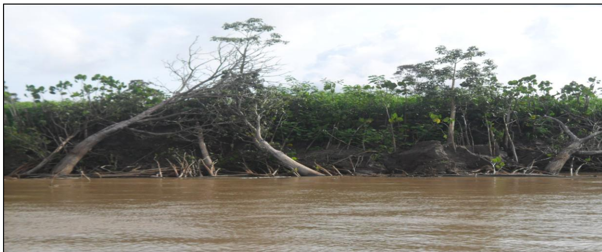
Figura 3: Processo de rastejamento e escorregamento nas proximidades da Comunidade de Arapemã. Foto: Eliana Marinho (06/11/ 2011).
