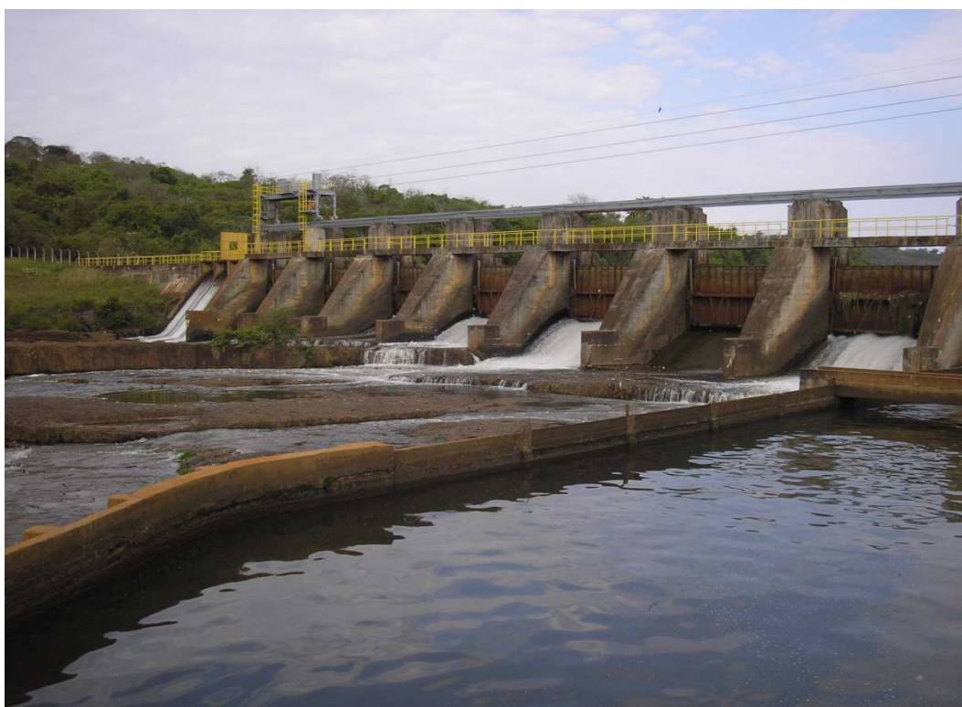
Foto 2 – Vertedouro da PCH Martins.
