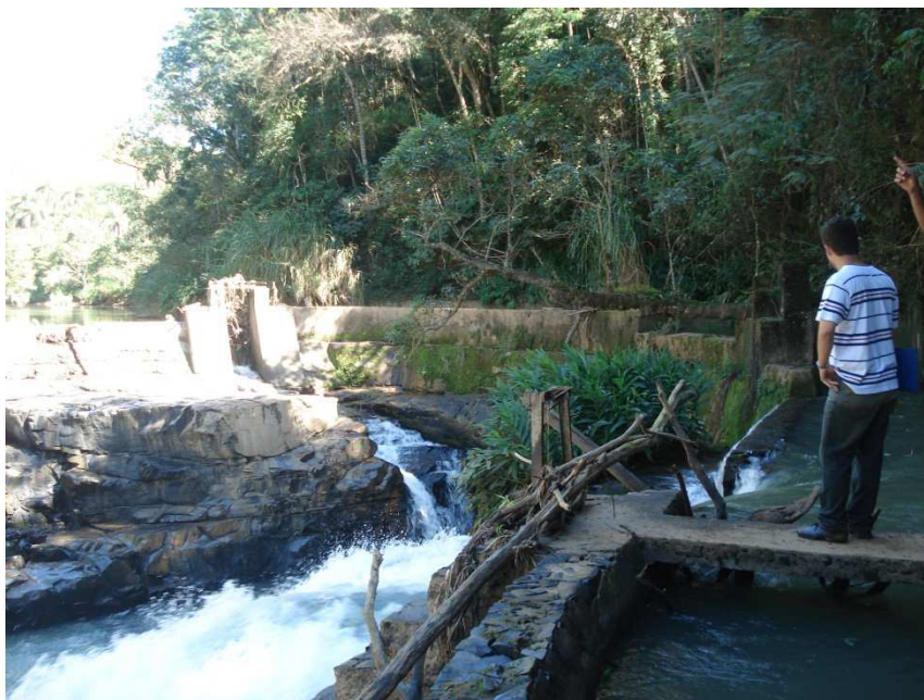
Foto 1 – Ruínas de antiga PCH localizada no rio Funchal, Dolores de Indaiá, MG, em 2008.
