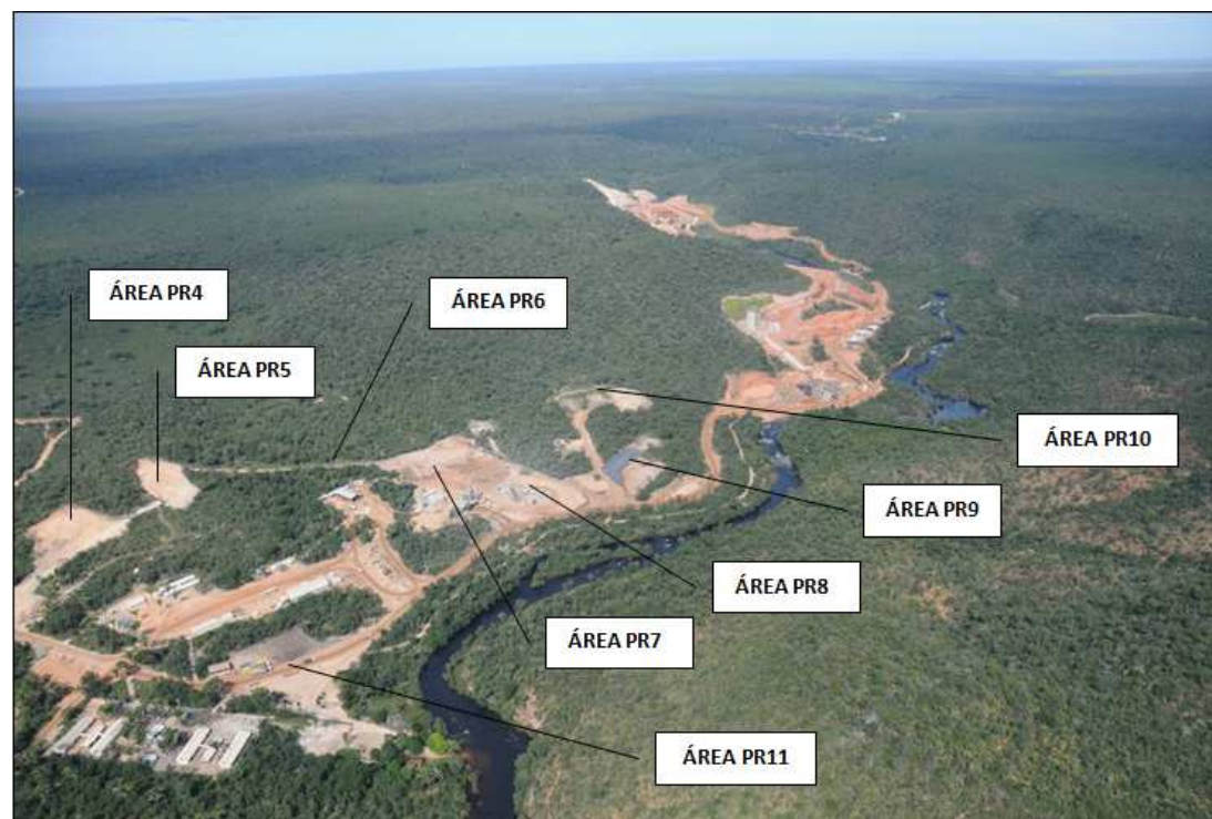
Figura -3- aspecto da área total a ser recuperada e o zoneamento realizado durante a implantação da PCH – foto tirada antes do desvio do rio para construção da barragem.
