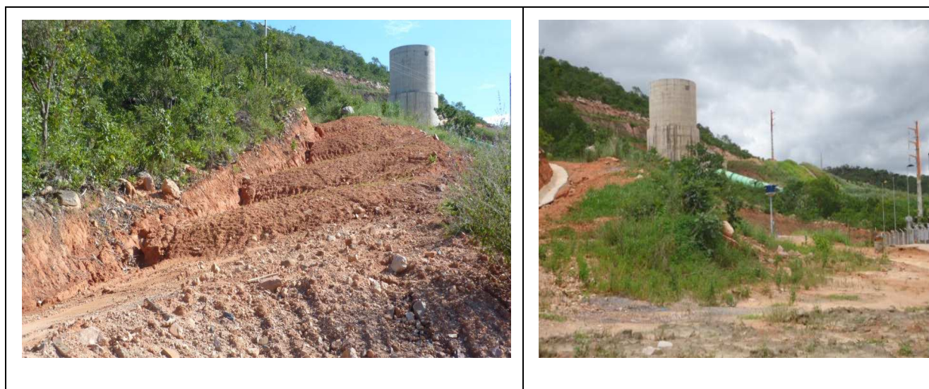
Figura - 4 - aspecto do talude que foi escalonado e que da acesso a chaminé de equilíbrio.
