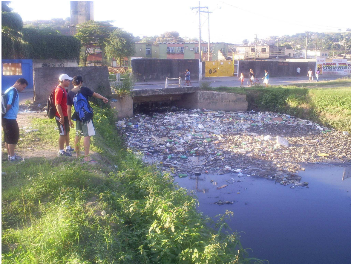
Foto 2 - Acúmulo de lixo, em um ponto do rio Imboassú. (Foto: Antônio Alexandre)
