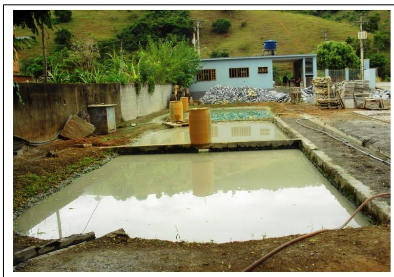
Figura 3: Tanques de decantação que viabilizam o recolhimento dos rejeitos e o reaproveitamento de água na Serraria Comércio de Pedras Paraíso.
