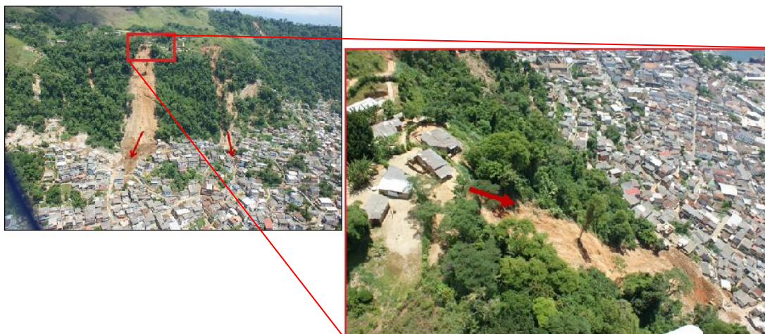
Fig. 4 e 5. Deslizamento no Morro da Carioca em detalhe. Uma saída d'água detonou o deslizamento.
