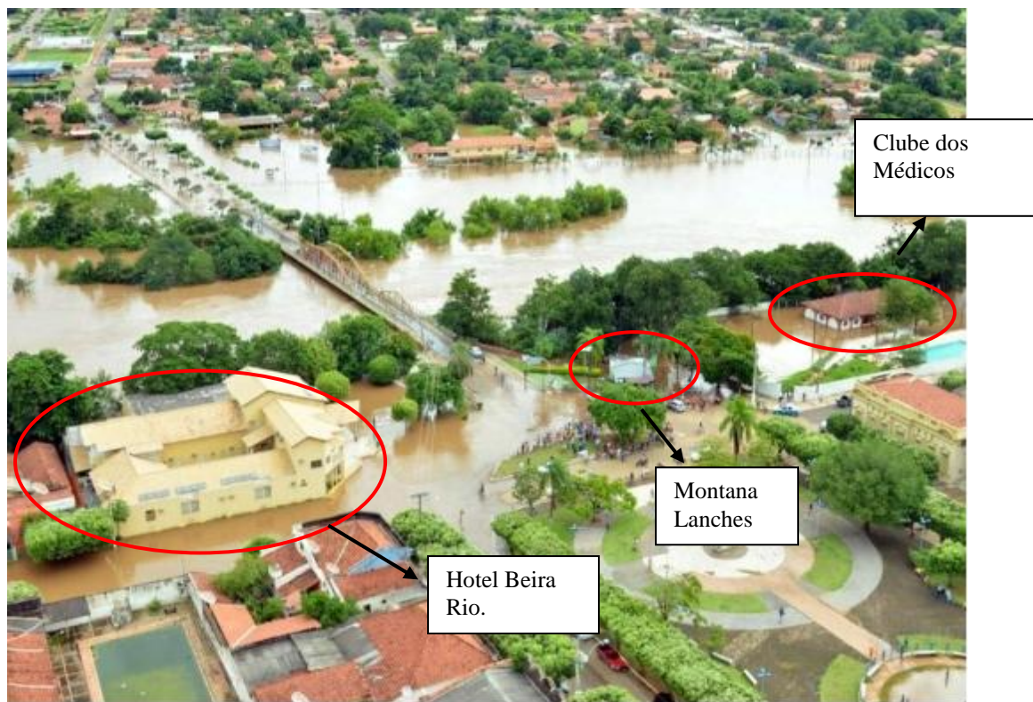
Figura 5 - Área de Preservação Permanente, na cabeceira da Ponte utilizada indevidamente por estabelecimentos comerciais e prestadores de serviço inundadas em Março de 2011. Fonte: Santos (2011).
