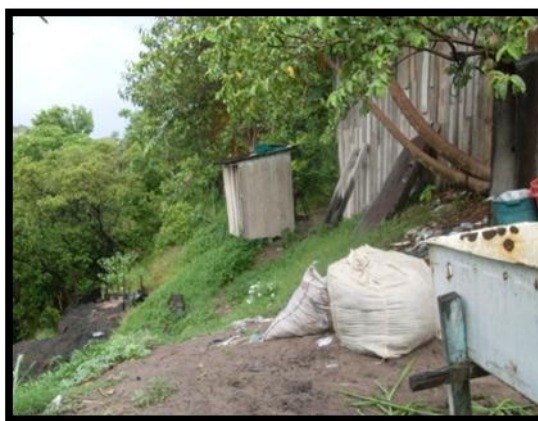
Figura 8. Casa vulnerável ao escorregamento. Fonte: Acervo próprio.
