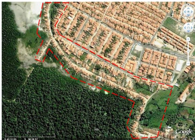
Figura 09 – Delimitação de área fortemente susceptível às inundações e aos fluxos de maré, na comunidade Vila Velha. Fonte: modificado de Google Earth, 2009.
