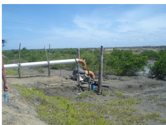
Figura 08: Bombas retirando água do manguezal
