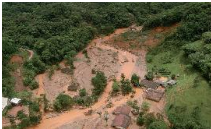
Figura 04: Casas e outras edificações construídas em APP de margem de curso d'água, atingidas por escorregamentos na região do Morro do Baú em Ilhota-SC.
