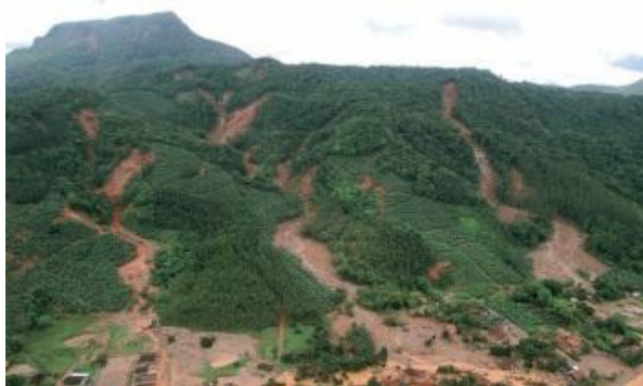
Figura 03: Vista do Morro do Baú em Ilhota-SC. Observa-se que os escorregamentos estão associados às áreas antropizadas e atingiram severamente as moradias edificadas em APP de margens de cursos d'água.
