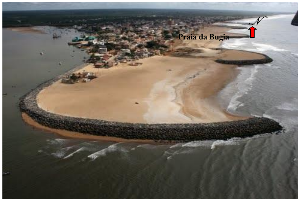
Figura 2 – Vista a partir do Pontal do Sul para a praia de Bugia, após a construção da proteção da linha de costa, consistindo de um enrocamento na foz do rio São Mateus e quatro "ferraduras". Fonte: http://geologiamarinha.blogspot.com/2010/09/protecao-da-linha-de-costa-no-espírito.html
