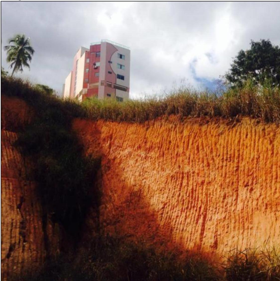
Talude com corte aproximado a noventa graus e com presença de ravinamentos.
