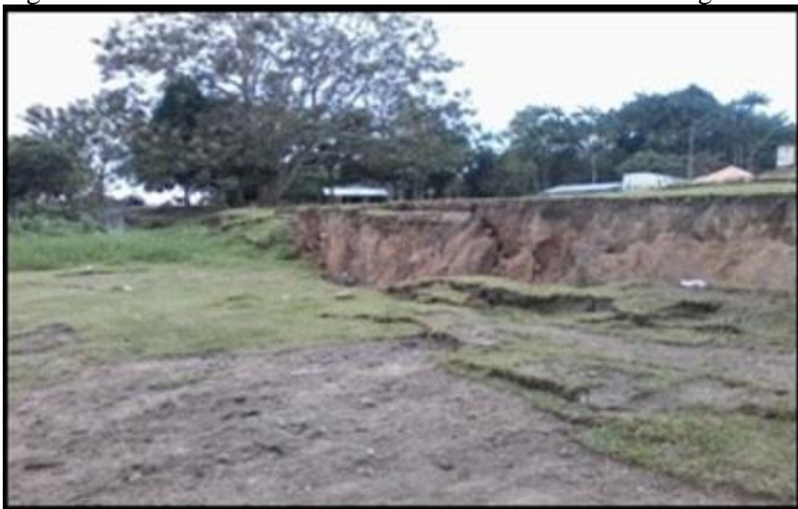
Bairro da Comara, em Tabatinga, com ocorrência de terras caídas em área residencial e de lazer.
