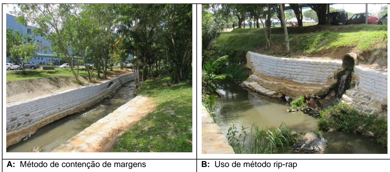
Figura 8 - Intervenção de engenharia no médio curso do canal do igarapé do Bindá
