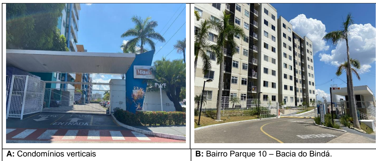
Figura 6 – Habitações construídas na área de nascente do Bindá.
