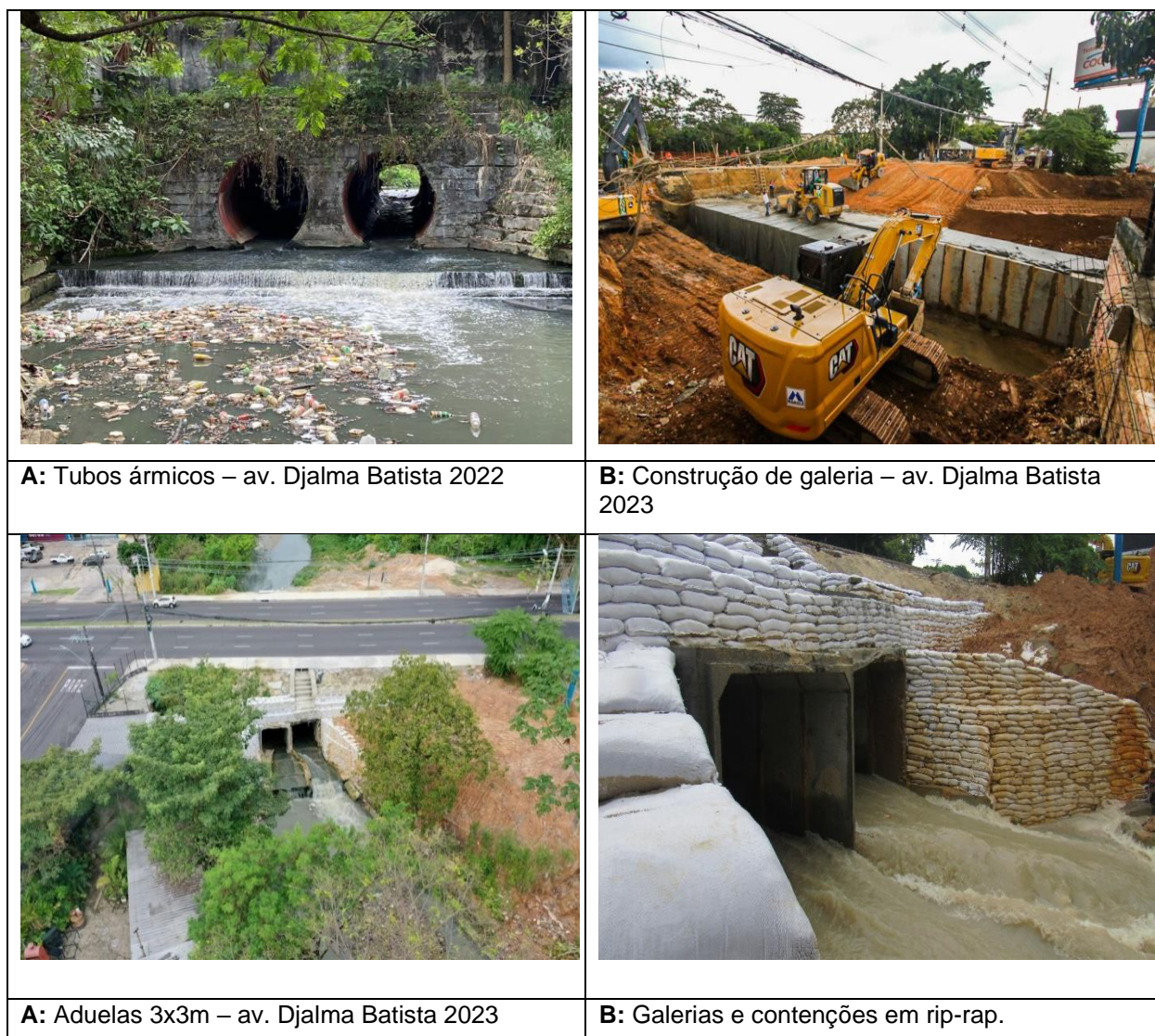
Figura 10 – Intervenção de engenharia de macrodrenagem ao longo do igarapé do Bindá.
