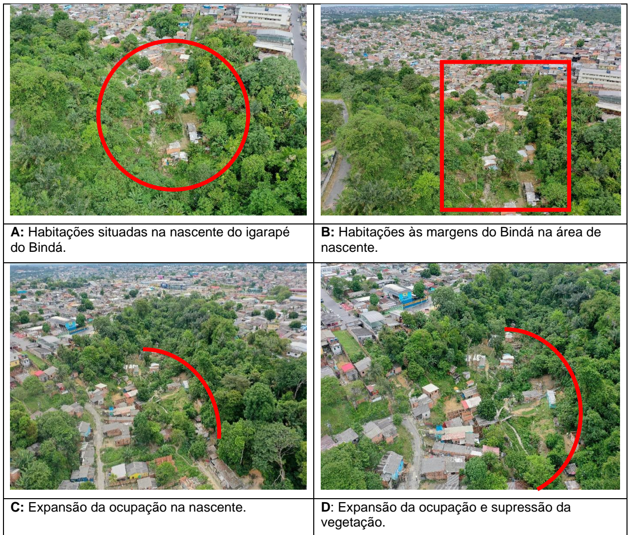
Figura 5 – Habitações construídas na área de nascente do Bindá.
