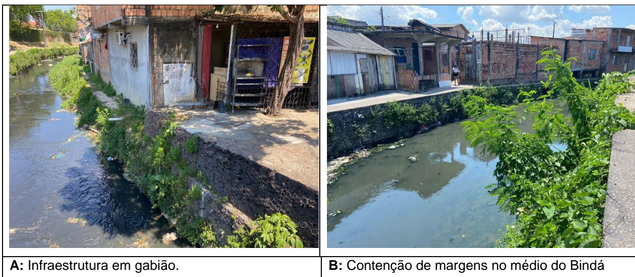
Figura 9 - Intervenção de engenharia do médio curso do igarapé do Bindá
