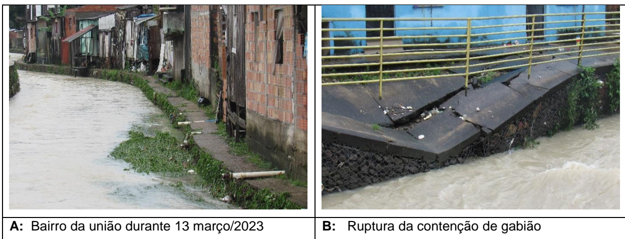
Figura 12 - Fluxo do canal do igarapé do Bindá
