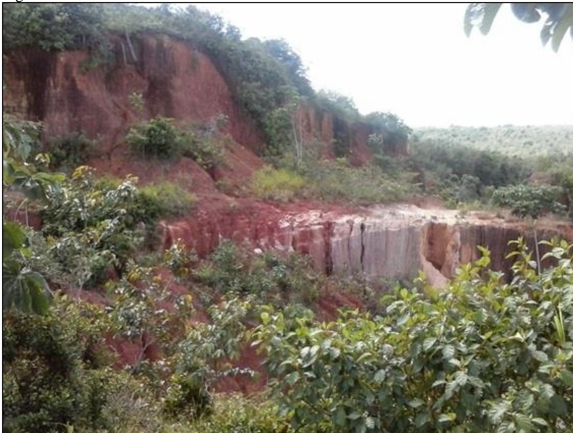
Voçoroca formada a partir de corte de estrada, norte da cidade de Ipixuna do Pará, em área de relevo colinoso (jul. 2014).
