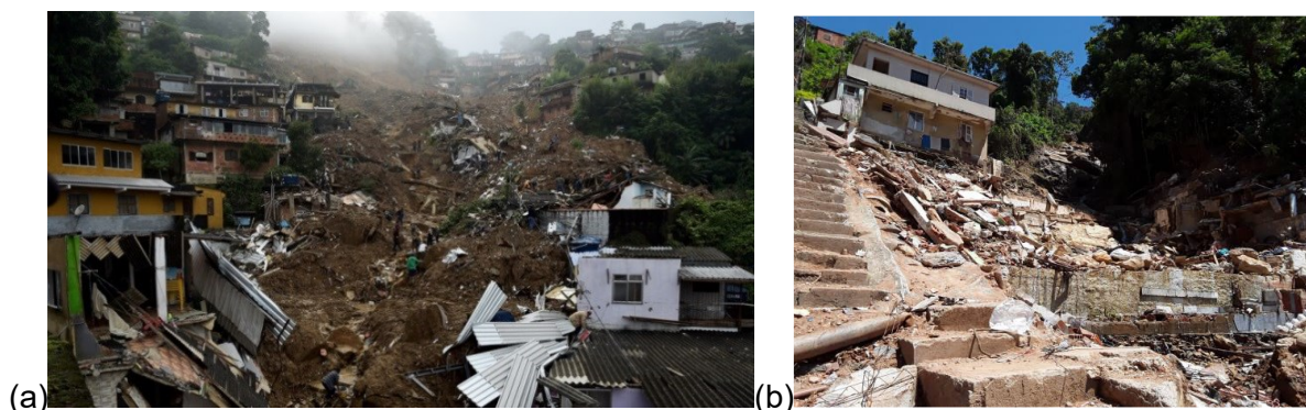
Figura 2. Desastres relacionados a sedimentos no município de Petrópolis em fevereiro de 2022: (a) Escorregamento translacional ( Fonte: METSUL, 2022); (b) fluxo de detritos. Fonte: MODESTO et al. (2022).
