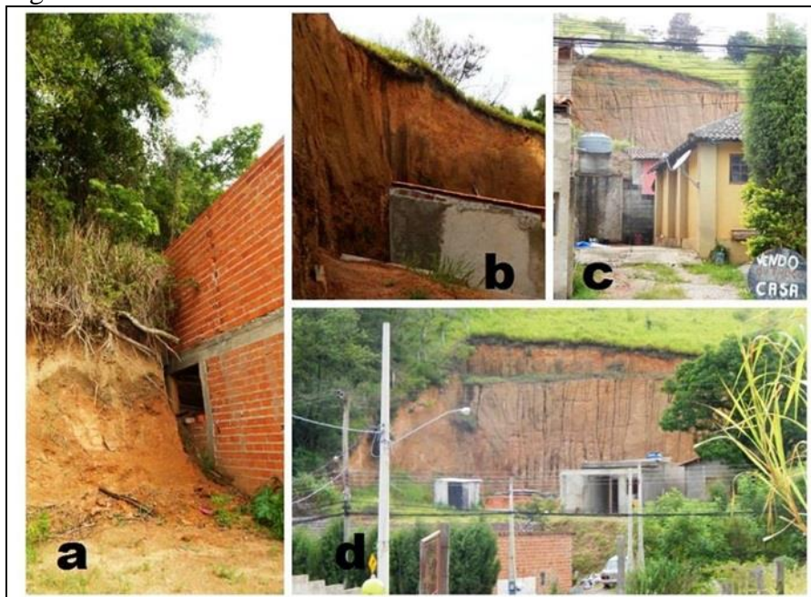
Taludes de corte, efetuados sem critérios, no Bairro Brigadeiro Tobias. Organização: CAROU, jan. 2014.
