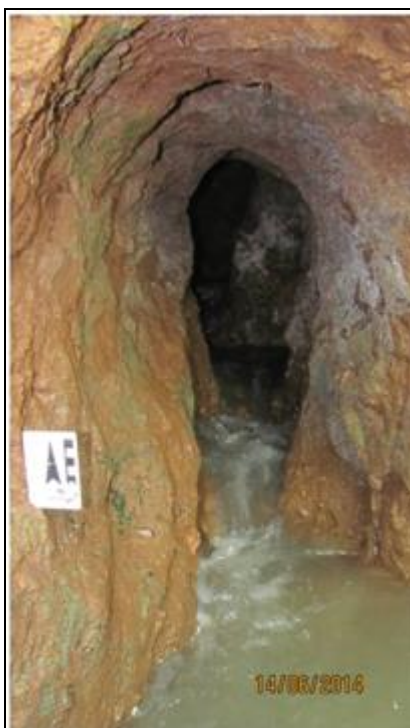
Representação do escoamento subsuperficial em um túnel em Candói PR
