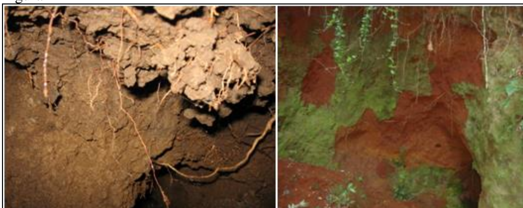
Desprendimento de agregados no interior de túnel e descolamento de placas
