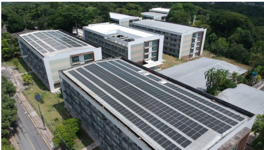
Figura 1. Edifício Solar da FCA. Campus Universitário da UFAM, Manaus, AM. Fonte: O Autor
