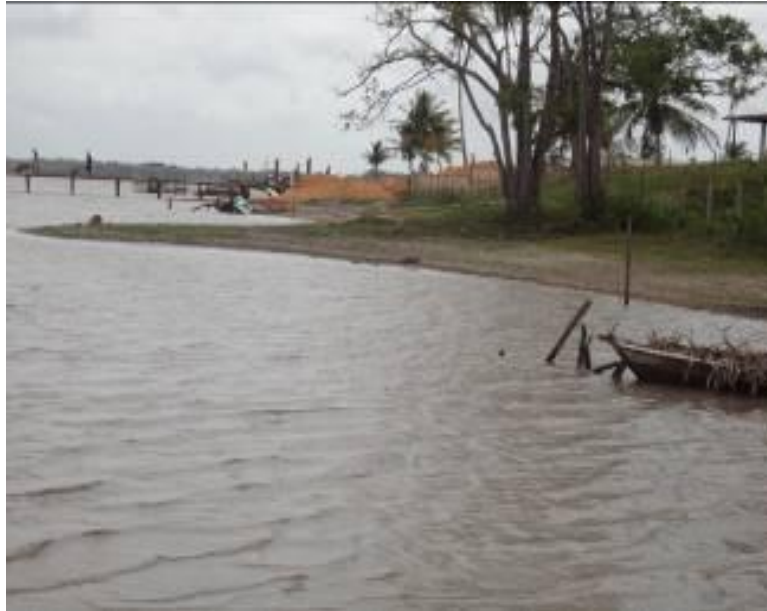
Figura 10: Aterramento para construção de casas, Vitória.
