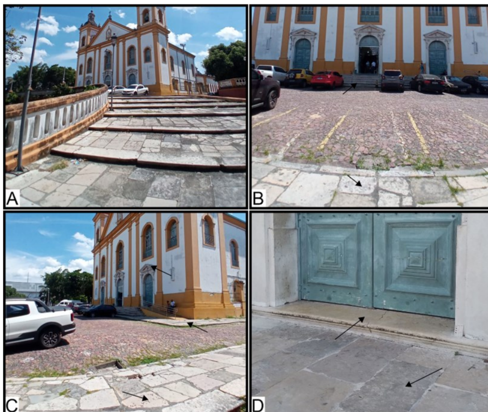
Figura 5. Formas de ocorrência dos calcários portugueses na porção externa da Catedral Metropolitana de Manaus (A) Escadarias frontais da Catedral com espelhos e degraus revestidos com calcário de lioz. (B) Escadarias de acesso à entrada frontal da Catedral e calçamento frontal externo com pavimentação em calcário de lioz. (C) Calçamento, meio fio e fachadas da Catedral revestidos com calcário lioz. (D) Detalhe do calcário de lioz revestindo a calçada frontal e utilizados na ornamentação da porta de entrada principal do Templo. Fonte: autores.
