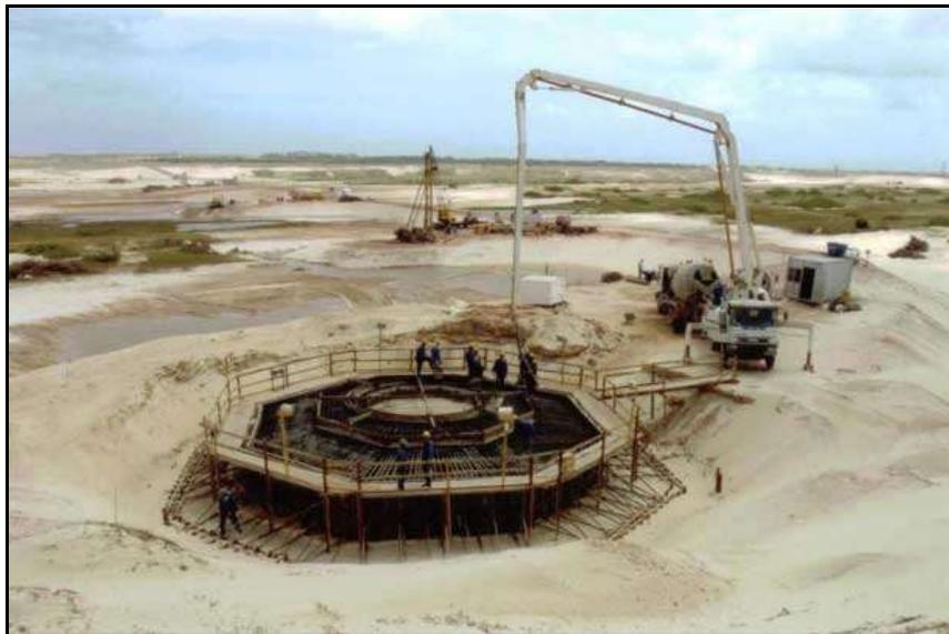
**Figura 3:** Imagem de concretagem da fundação de torre de parque eólico. Fonte: <http://www.piniweb.com.br/construcao/infra-estrutura/imagens/i167554.jpg>.
