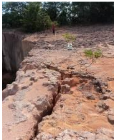
FIGURA 5: Monitoramento da voçoroca a partir da linha mestra. Borda da voçoroca com grandes fendas. Foto de Sidney Araújo Glória, 2010.
