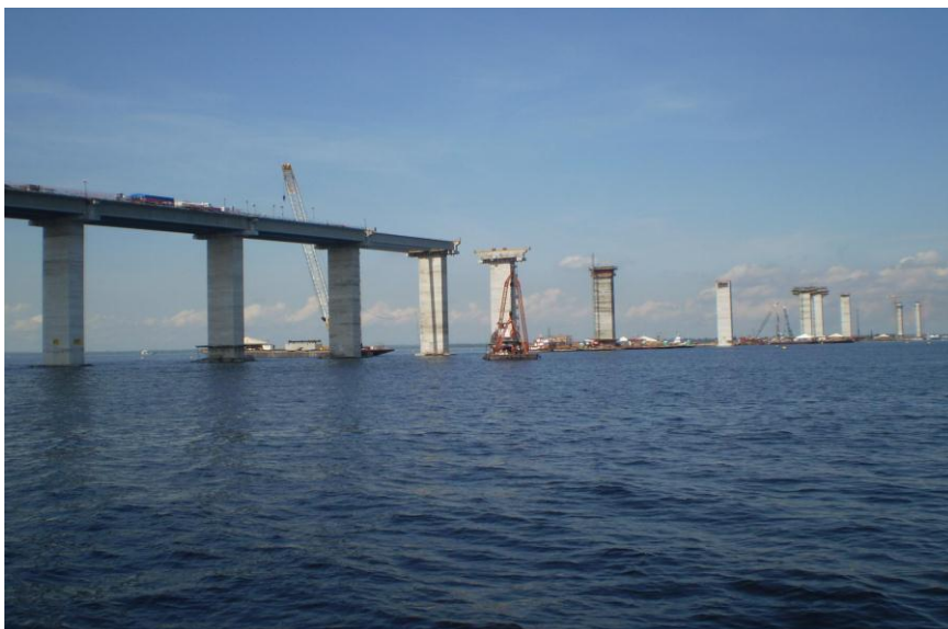
Fig. 03 – A construção da ponte saindo de Manaus Foto: Marcos Castro - junho/2009
