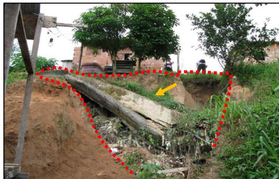
**Figura 08:** Voçoroca 5 (traçado vermelho) com presença de canaleta (seta amarela), semi-destruída e instabilizada pela ação da água.
