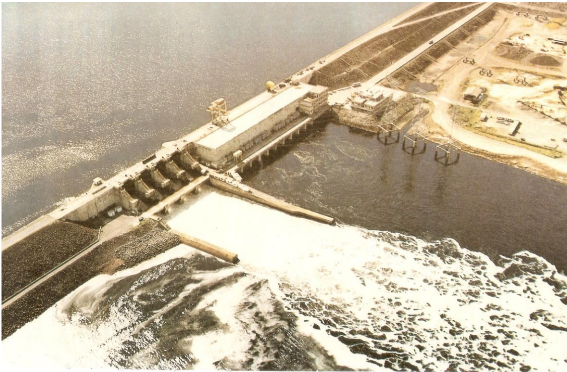
Figura 13 – Vista aérea da UHE Balbina no mês de maio/junho, quando o regime hidrológico do rio Uatumã está na cheia e turbinas da usina estão operando em nível alto. Fonte - UHE Balbina - Memória Técnica (1997).
