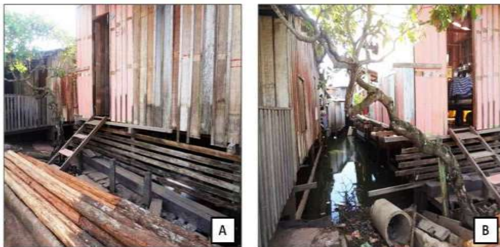
Figura 05 - Representação fotográfica de casa em processo de suspensão. Vista frontal (A). E vista lateral da casa (B). Bairro Santa Rita de Cássia. Cidade de Parintins. AM/BR
