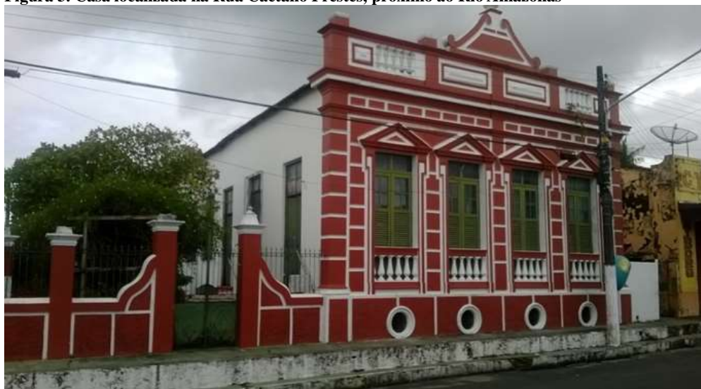
Figura 3. Casa localizada na Rua Caetano Prestes, próximo ao Rio Amazonas
